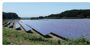
庄内・遊佐太陽光発電所
